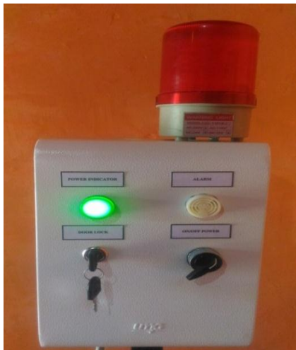
Gambar 4. Rangkaian Mekanik Box Panel
