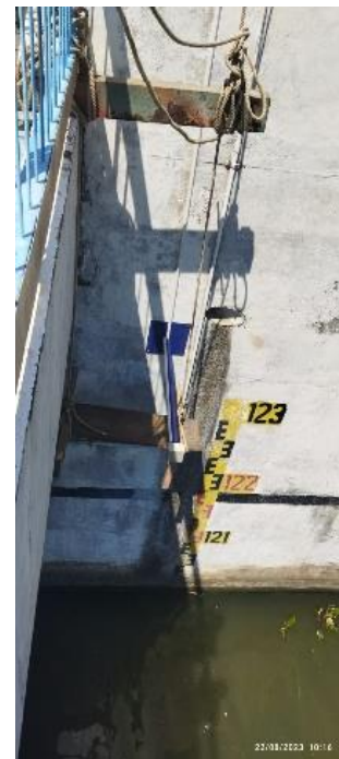
Gambar 7. Sensor ultrasonik yang terpasang pada bendungan
